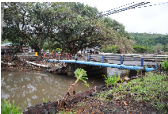
写真 3 2009年サモア諸島沖地震の際のアピアにおける橋梁添架の上水道管の応急復旧状況
