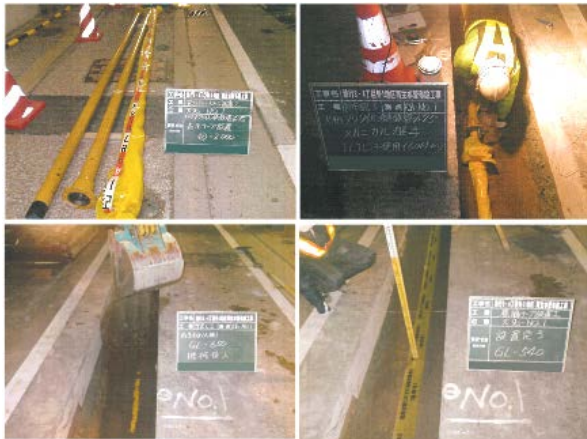
図-7 再生水管布設状況
