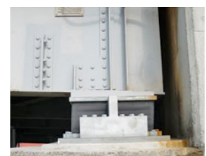
写真-1 検査路による近接手段の確保 写真-2 仮支持のための主桁の補強の事例
