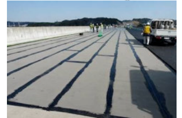
写真-4 シート系防水工の例
