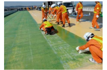
写真-5 塗布系防水工の例
