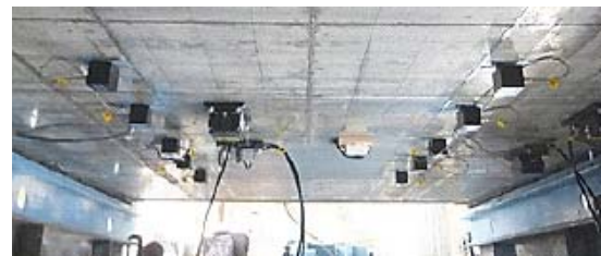
写真-2 床版下面のセンサ設置状況
