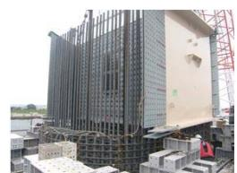
クレーン付き台船による張出し架設
