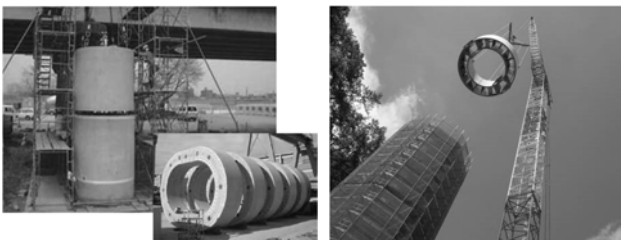
プレキャスト橋脚の例 (鉛直方向プレストレスにより接合)
