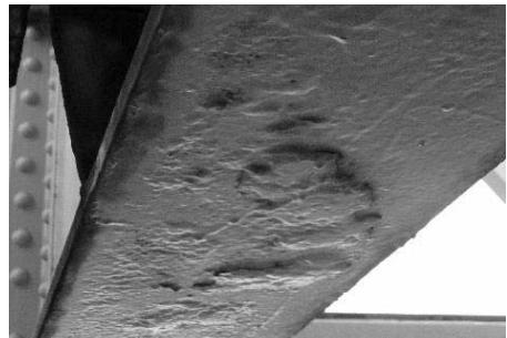
図6 塗膜下での腐食例
