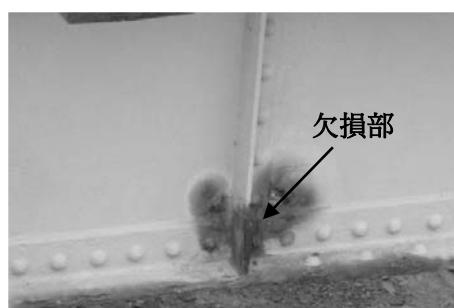
図4 腐食による部材の欠損事例
