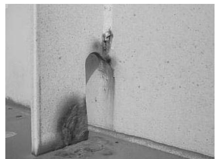
図1 局所的な塗膜劣化・腐食の例
