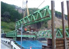
中間脚(中間ベント、中間杭)を設けた尺取架設で、より小さな重機で施工ができ工事費用を低減できます。
