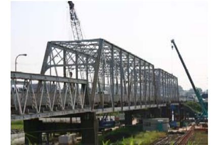
江ヶ崎跨線橋(2009年) 6
