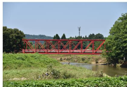
越路橋→不動沢橋（長岡市）
