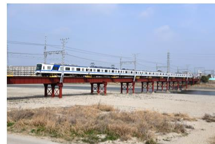
南海電鉄・大和川橋梁
