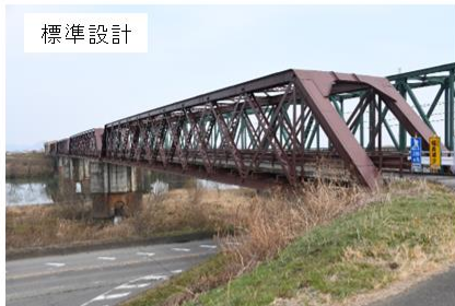
旧東海道線・揖斐川橋梁
