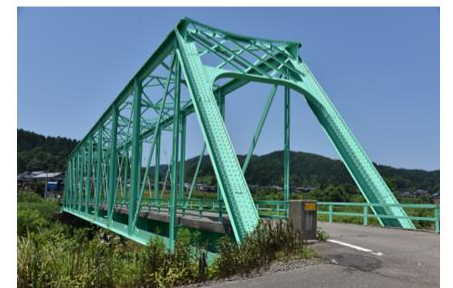
越路橋→岩田橋（長岡市）
