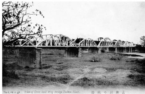
九州鉄道・高瀬川橋梁
