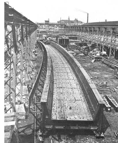
中央線・万世橋架道橋 （横河橋梁における仮組）
