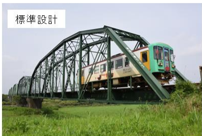
樽見鉄道・揖斐川橋梁
