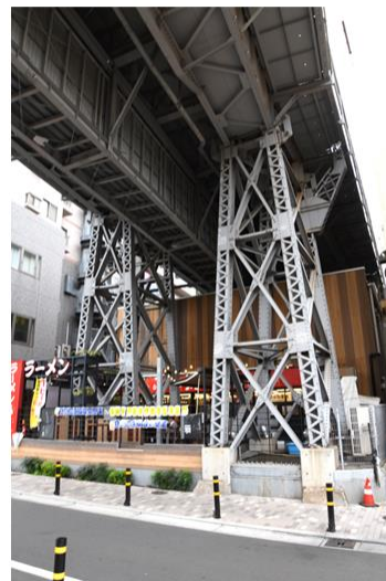
東急電鉄・五反田付近高架橋
