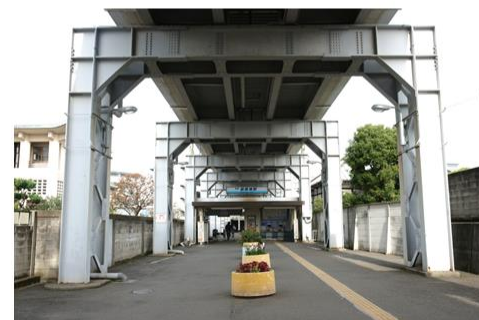
京浜急行・新馬場駅付近高架橋
