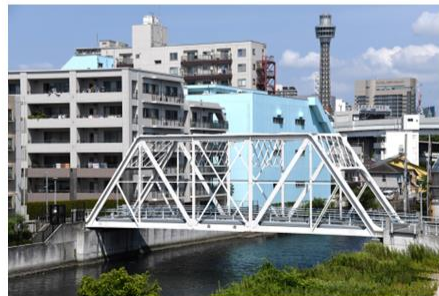
江ヶ崎跨線橋→霞橋（横浜市）
