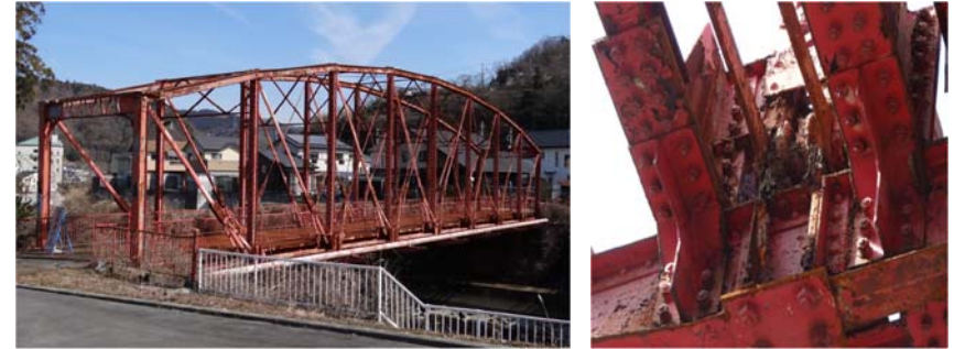
改修前全景 (平成27年12月)
