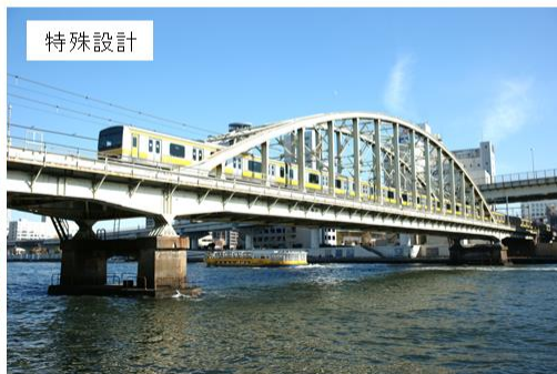
総武線・隅田川橋梁
