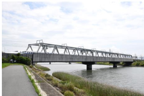
東海道新幹線・江川橋梁 ※防音壁による遮音
