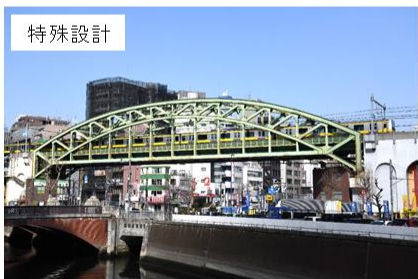
総武線・松住町架道橋
