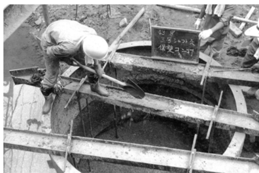
図3.1.2-6 継手部（シャフト部）防水状況（地山側：シート防水+保護コンクリート） 6)
