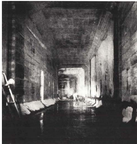
図2.3.1-2 完成したイコス式隧道 1)
