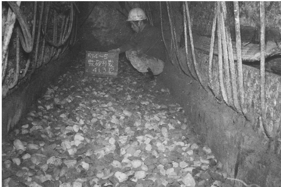
図3.1.2-2 ケーソン間接手部の状況（掘削完了敷砂利完了時の状況） 6)
