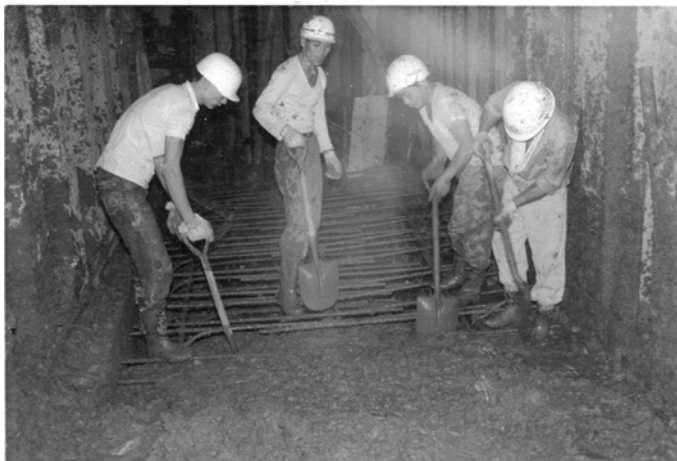
図3.1.2-4 ケーソン間継手部施工状況（コンクリート打設） 6)
