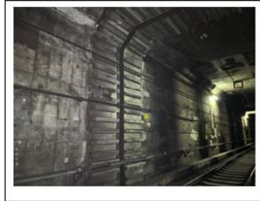
図3.3.3-8 伸縮継手現況写真（側壁部）
