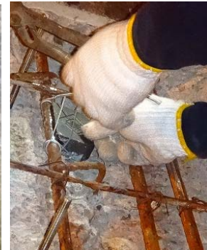
図3.3.2-3 犠牲陽極材と設置状況 1)
