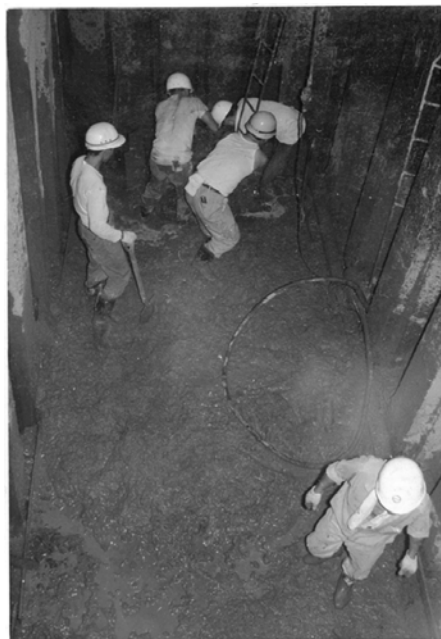
図3.1.2-4 ケーソン間継手部施工状況（コンクリート打設） 6)
