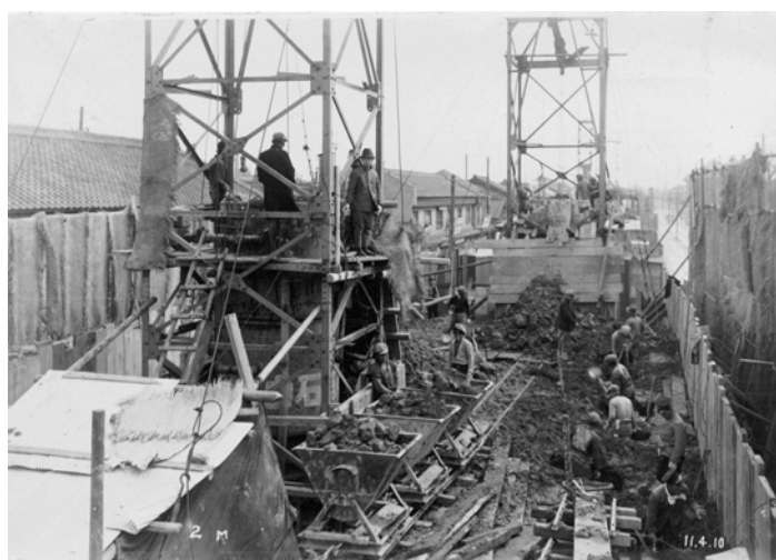
図3.1.1-15 ケーソン沈下状況（上部へ土砂载荷） 2)
