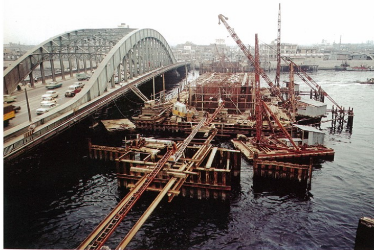
図3.1.1-9 ケーソントネル施工状況 4)
