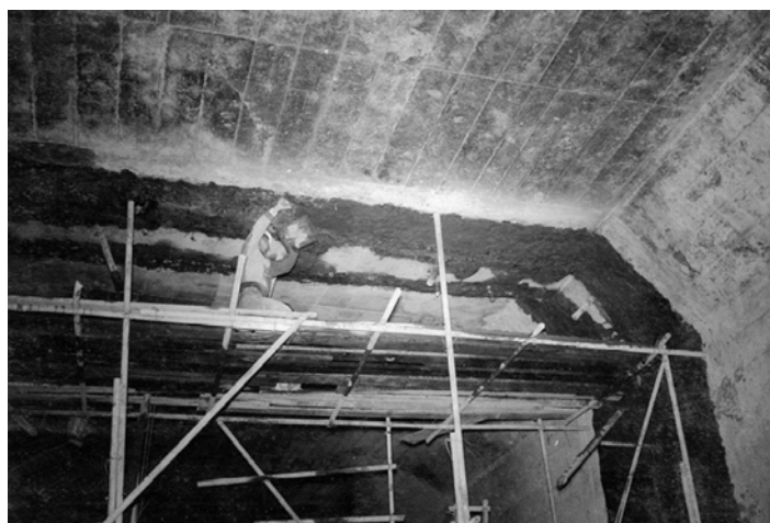
図3.1.2-5 継手部防水施工状況（モルタル防水） 6)
