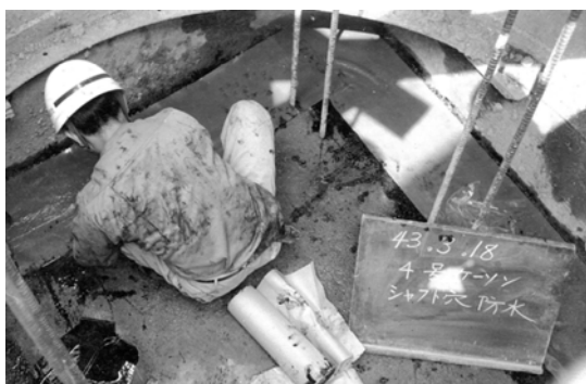
図3.1.2-6 継手部（シャフト部）防水状況（地山側：シート防水+保護コンクリート） 6)
