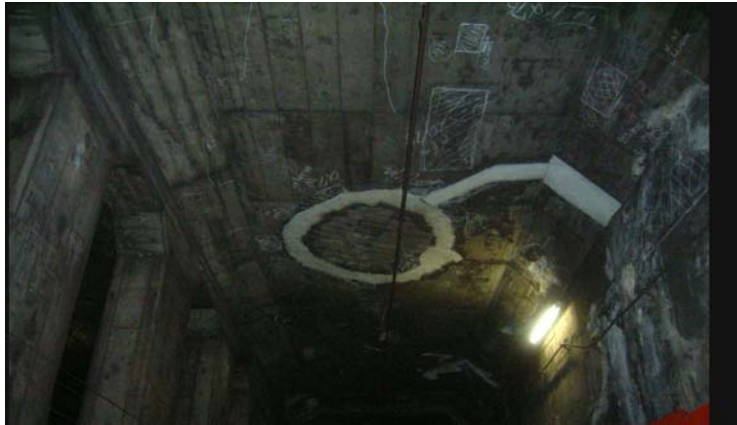
図2. 2. 2-3 シャフト孔跡の補修例 2)
