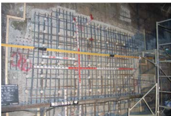
図3.3.2-8 犠牲陽極材設置状況
