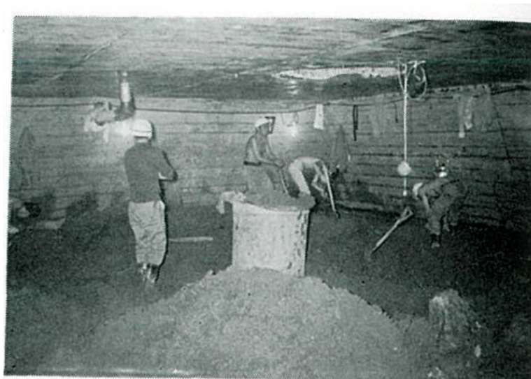
図3.1.1-6 圧気掘削の様子 3)
