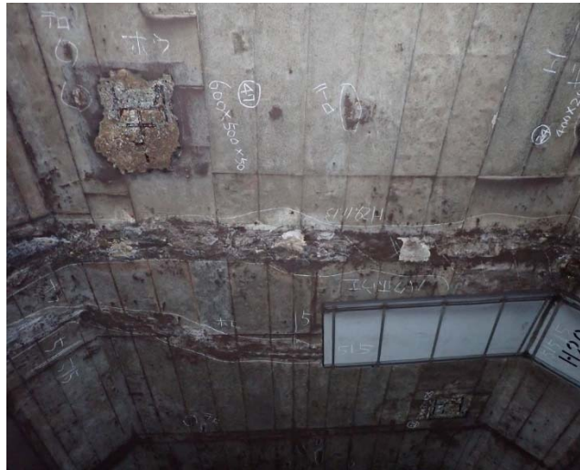
図 5.3 上床版導水工の様子
