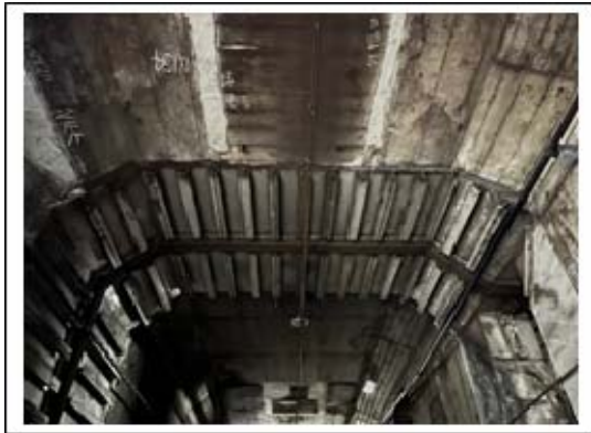
図3.3.3-7 伸縮継手現況写真（上床部）
