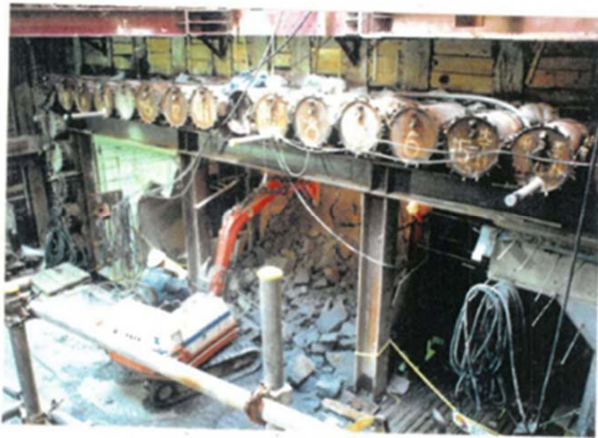
図 5.1.1-5 トレンチ中央坑口部掘削の様子 2)
