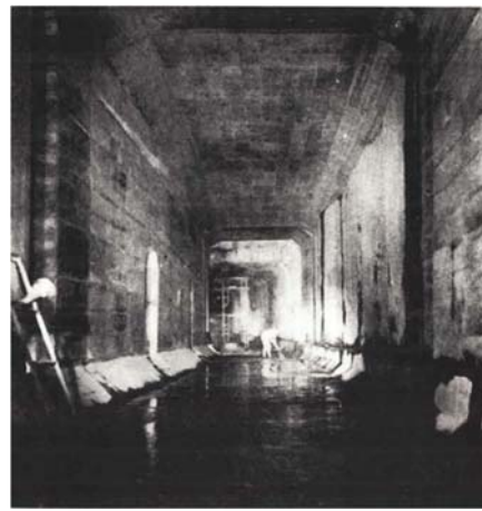
図 4.1.1-2 完成したイコス式隧道 2)
