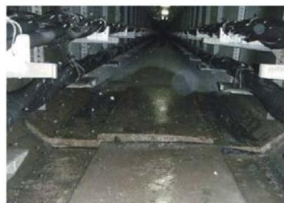
写真 3.4-2 洞道の被害（段差）
