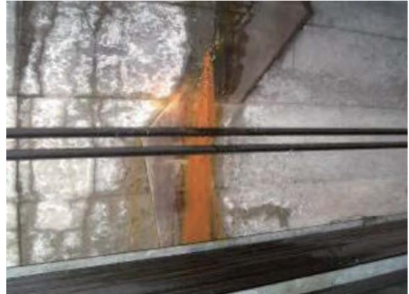
写真 2.3-2 南北線における漏水増加箇所②
