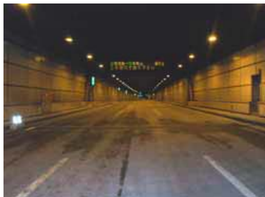
写真 3.2-2 復旧後の状況
