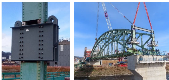
写真-1 吊金具(左)・吊上げ状況(右)
