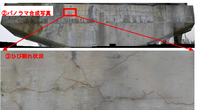
写真-5 ひび割れ自動抽出技術の活用
