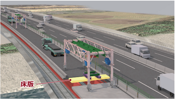
東名多摩川橋の分割床版取替イメージ
