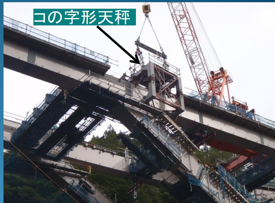
写真 - 専用吊天秤による下部アーチの架設 [左]への字形天秤, [右]コの字形天秤
