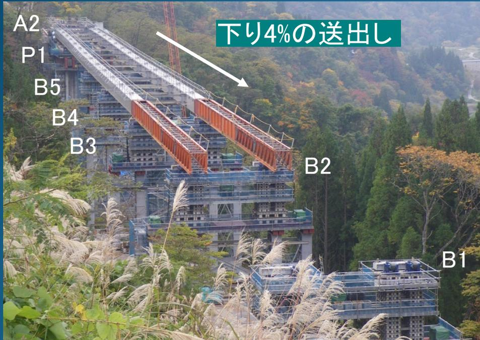
写真 - 補剛桁の送り出し
