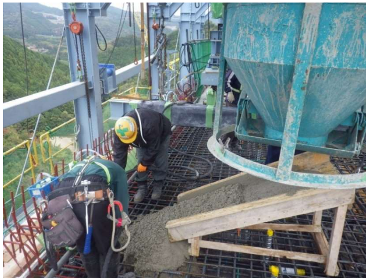
STEP7 床版コンクリート、ストラット受台打設
