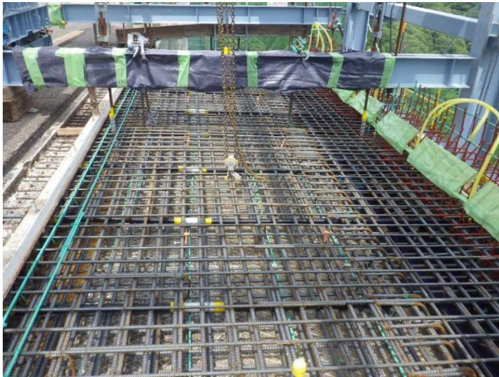
STEP5・6 配筋、PEシース、PC鋼材配置
