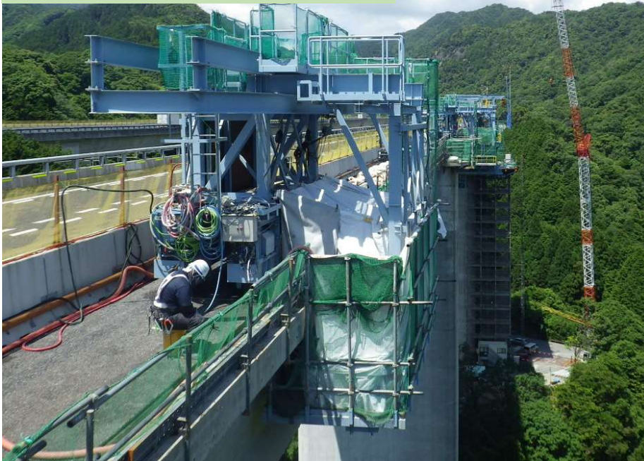
壁高欄撤去作業車
