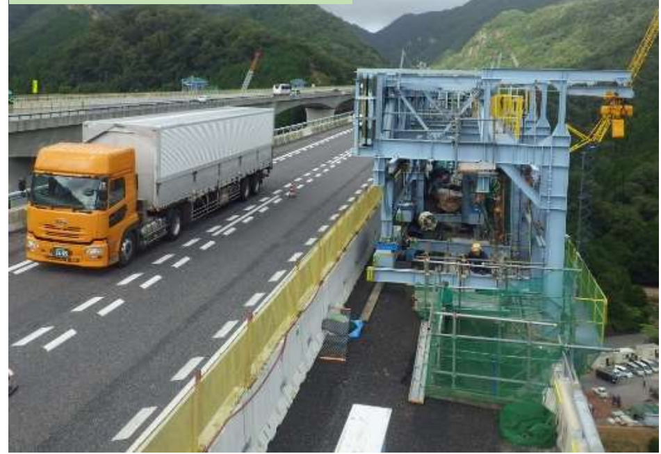
床版施工作業車
