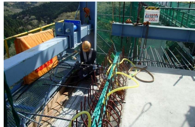
STEP9 PC鋼材緊張、グラウト充填
