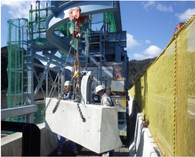
STEP1 既設壁高欄撤去（専用の撤去台車）
