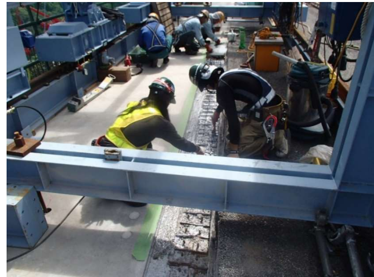
STEP8 既設床版上面復旧
