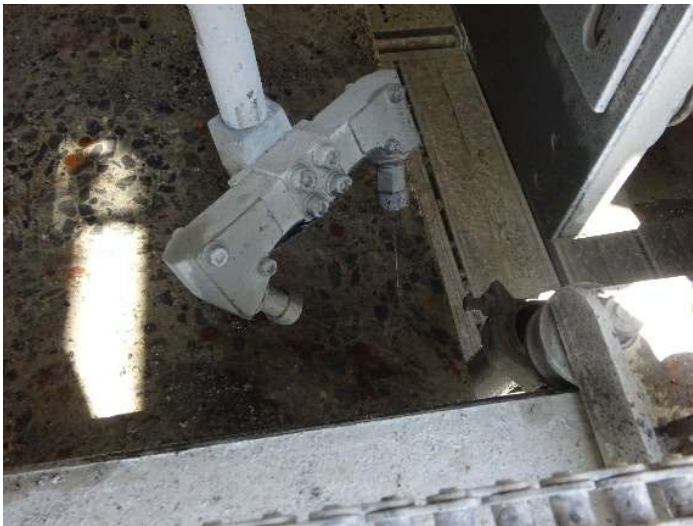
STEP2 既設床版撤去
