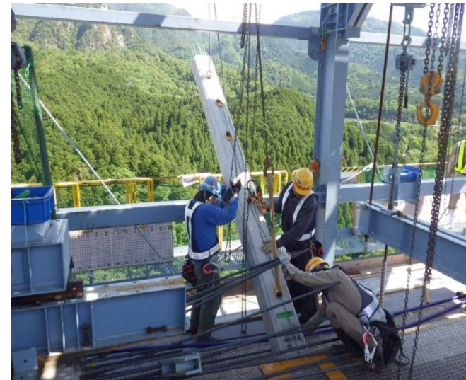
STEP4 ストラット建込み
