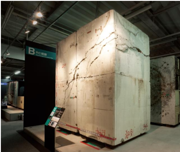
図-2 被災構造物の展示状況
