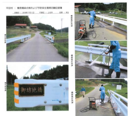
図-3 住民が作成した橋梁点検報告書
