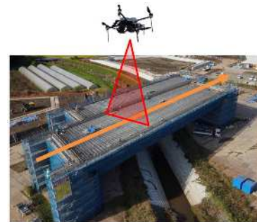
図 1 ドローンを用いた床版配筋の撮影
