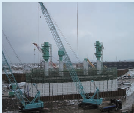
ニューマチックケーソン工法により新幹線と県道一体型の橋脚を構築します。
