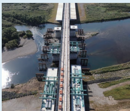
出水期には仮橋上部工を一時撤去します。
