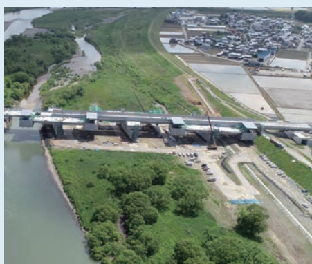
上部工は張出架設工法により建設します。
