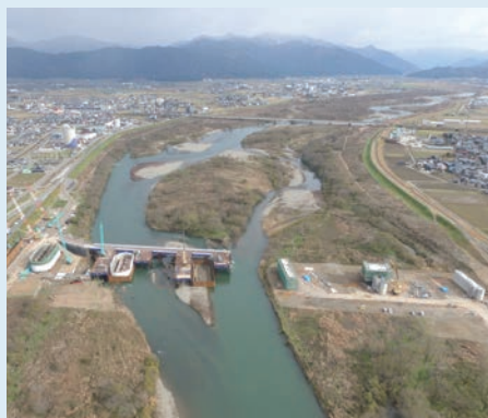
流水部は仮橋および仮設ステージを設置し施工します。
