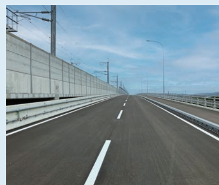
舗装、高欄等の付属物を施工して完成です！
