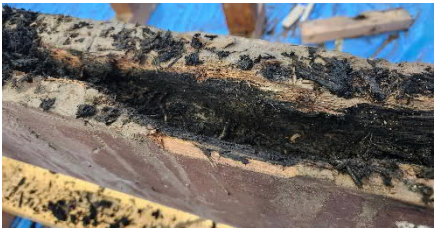
図2 主桁上面からの腐朽状況
