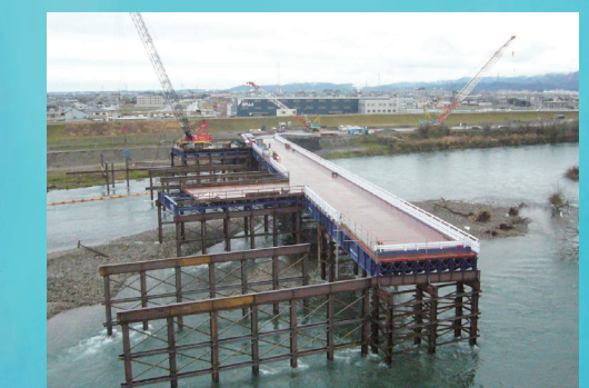
仮橋・仮設構台
