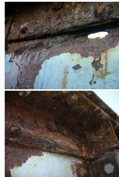
写真②③ 不可視部
