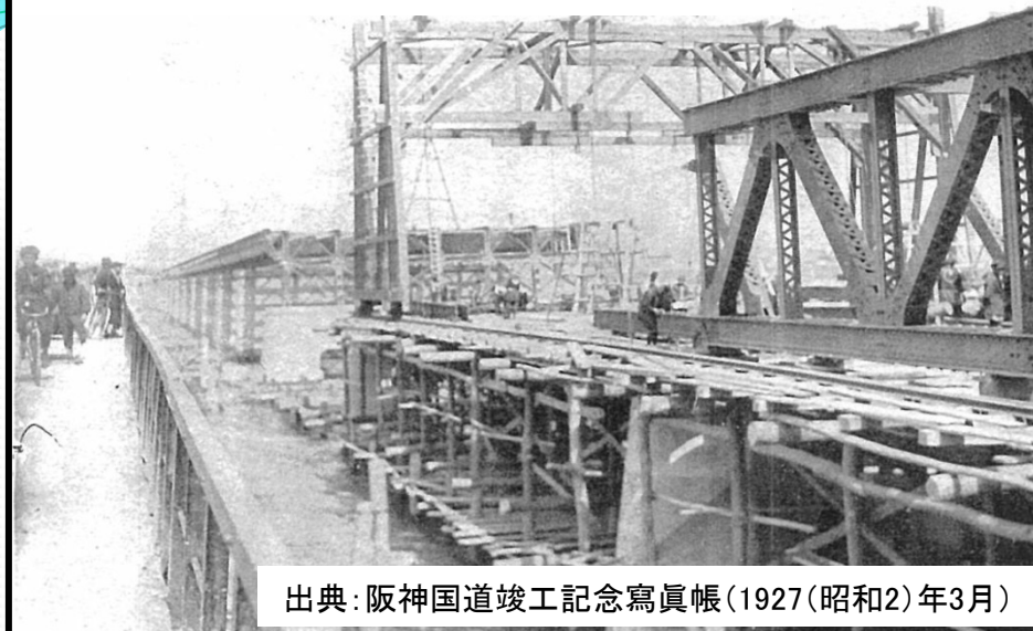
橋梁架設工事 1925(大正14)年頃
