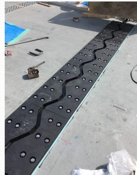
伸縮装置設置
