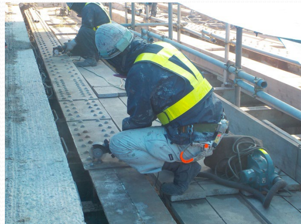
主桁上フランジの素地調整
