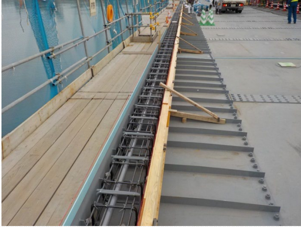
地覆配筋・型枠
