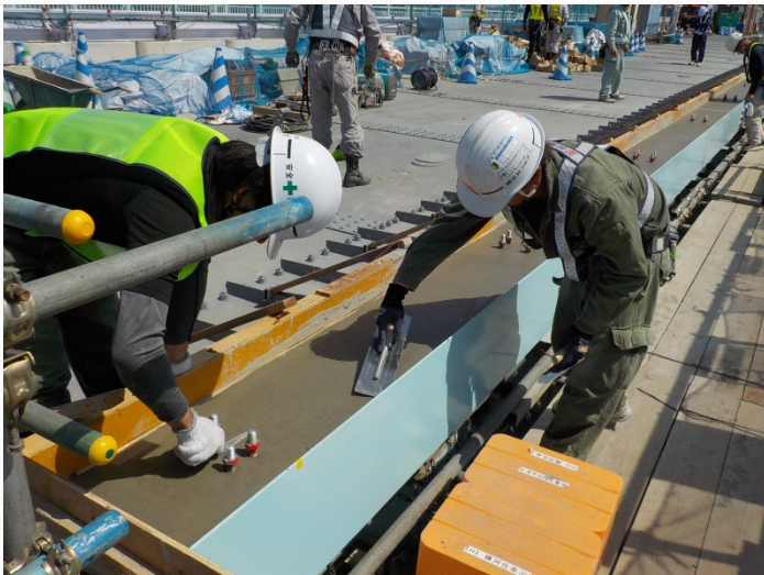
地覆コンクリート打設
