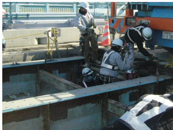
高さ調整フィラープレート設置
