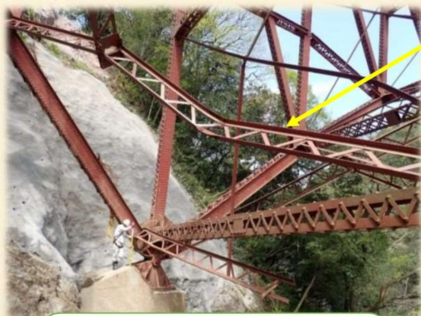
対傾構は大きく変形・破断
