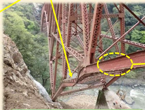
下弦材は土砂により大きく変形
