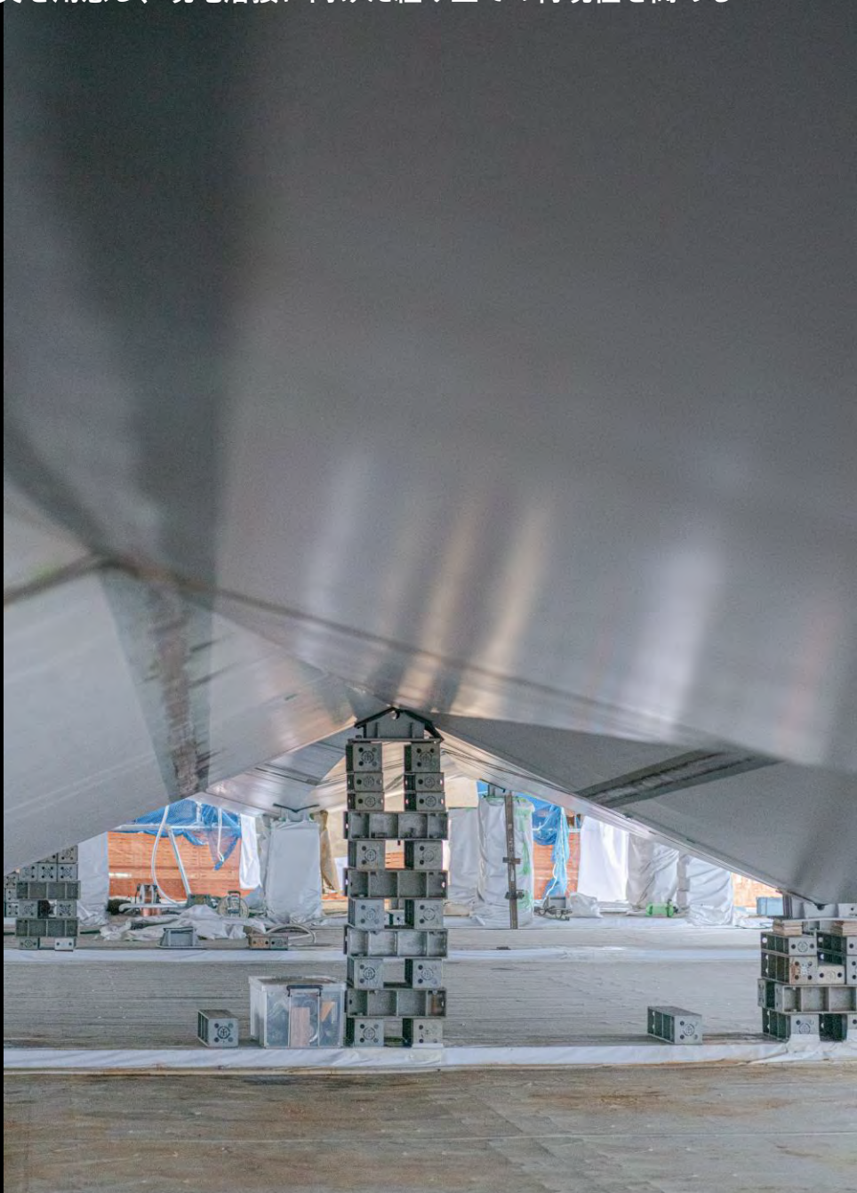
場所毎に全て異なる 3次元の治具を用意し、現地溶接に向けた組み立ての再現性を高める
