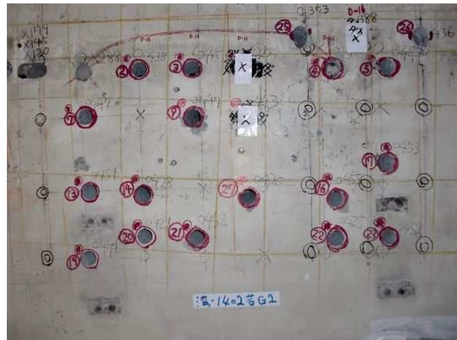
削孔完了後の状況
