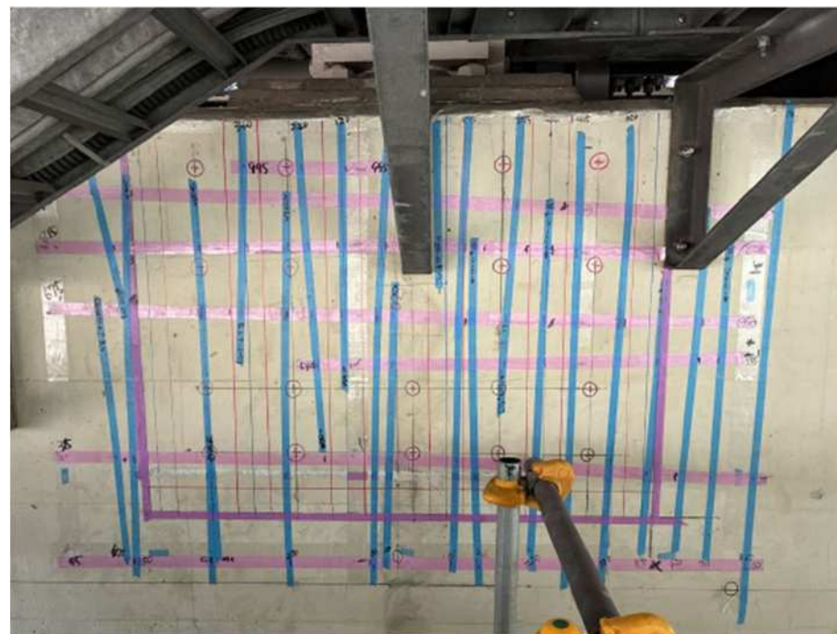
RC橋脚横梁の鉄筋探査の結果
