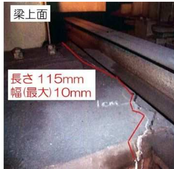
上側主鉄筋10本中9本が破断
