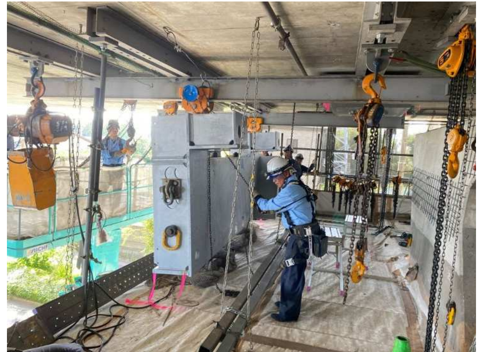
ブラケット架設状況
