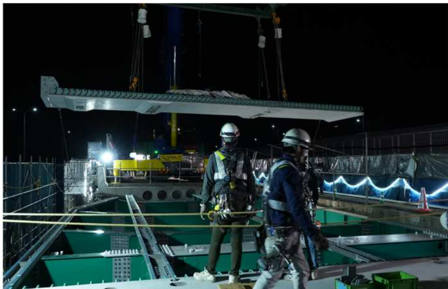
床版架設①
