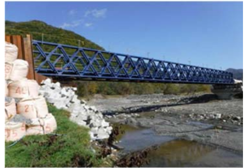
写真-5.3.2 千露路橋応急組立橋 3)
