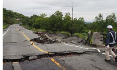
(b) 土工部の崩落
