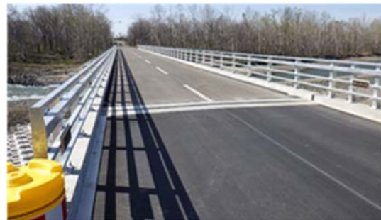
(c) 埋め戻した橋台背面部分
