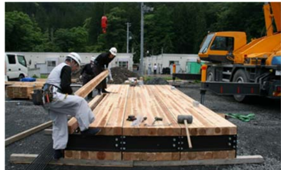
写真-5.1.2 安堵橋の組み立ての様子
