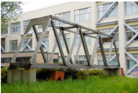
写真-5.1.3 移設前の木製トラス実験橋
