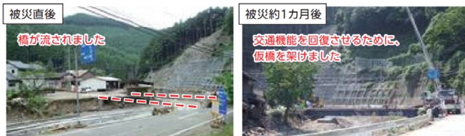
写真-2.2.4 中島橋の復旧の様子 9)
