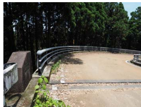
(b) 支承損傷による伸縮装置部のずれ
