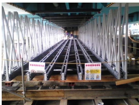
写真-5.4.1 施工状況
