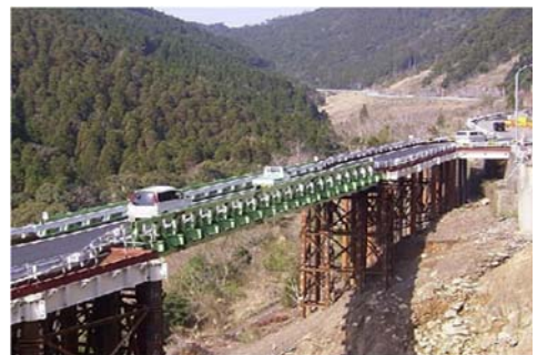
写真-5.3.4 日南災害復旧仮橋 5)
