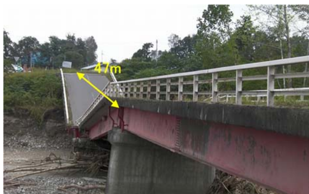
写真-2.3.6 上美生橋(帯広市, 道道55号)
