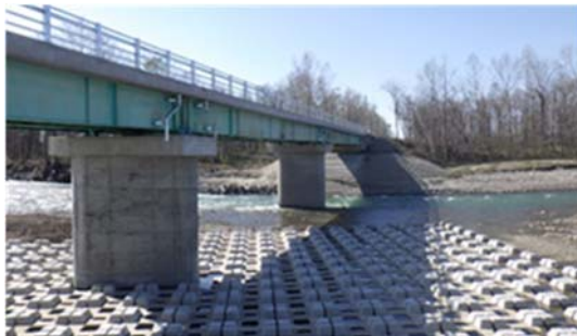
(b) 復旧後の様子
