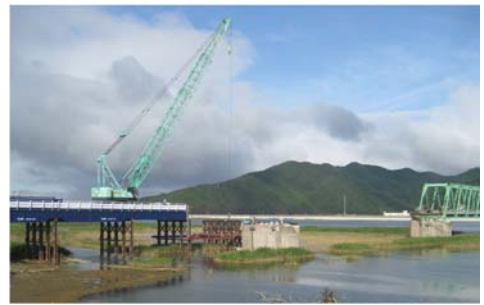
写真-5.3.1 新北上大橋応急組立橋
