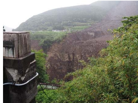
(b) 落橋した桁の一部のみが確認できる
