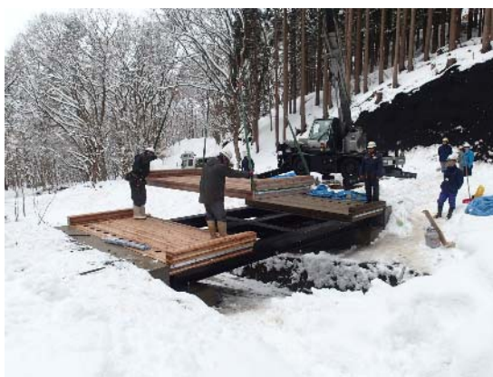
写真-5.1.5 CLT 床版橋の施工の事例
