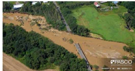
(b) 上空からの被害状況 22)
