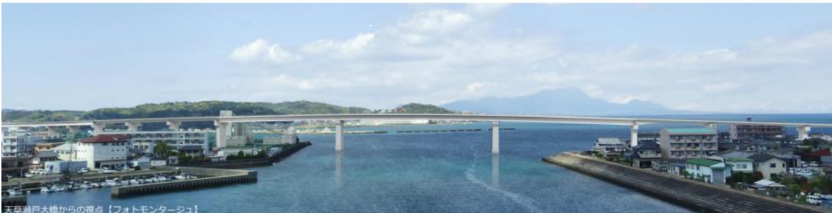
※概略予備設計段階のものであり、橋梁名称は仮称。(2023年2月25日に「天草未来大橋」として開通)
