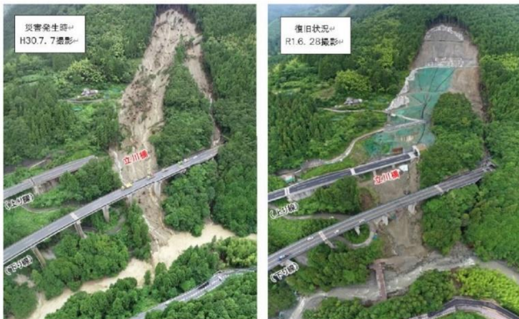
写真-Ⅱ.6 立川橋の被災と復旧状況図 6)
