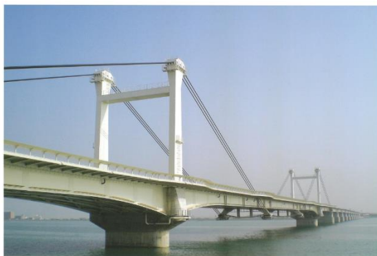
写真-4.4.1 阿波しらさぎ大橋 12)
