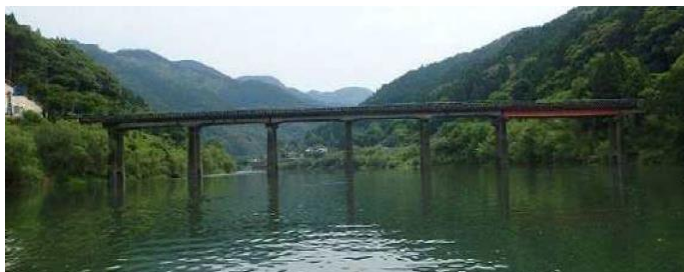
写真-4.3.6 神瀬橋（流出前）
