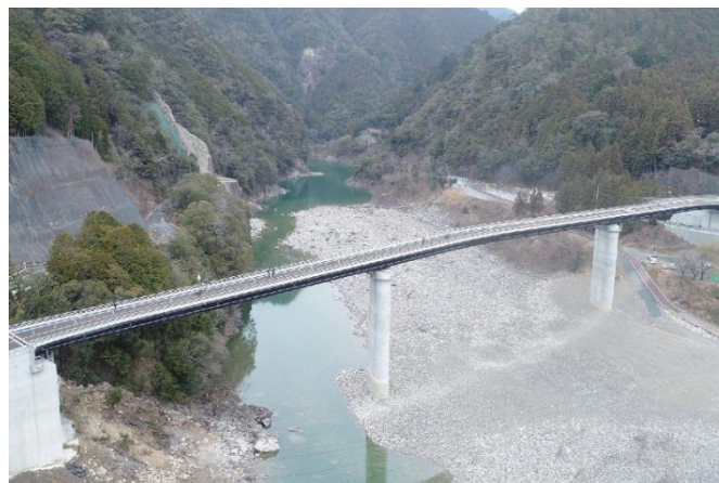
写真-4.3.1 新々原田橋全景 12)
