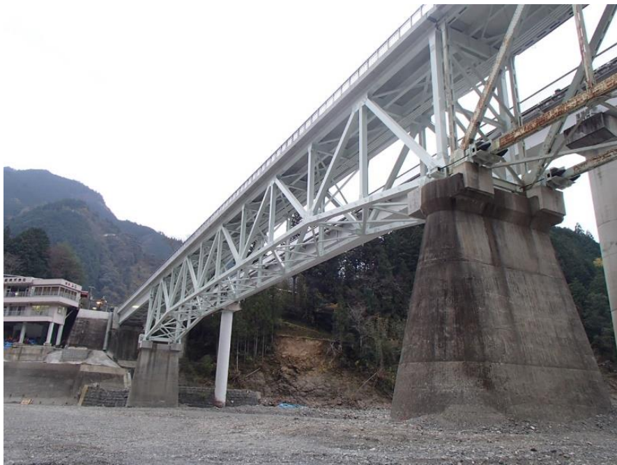
写真-Ⅱ.10 折立橋の復旧後の写真 10)
