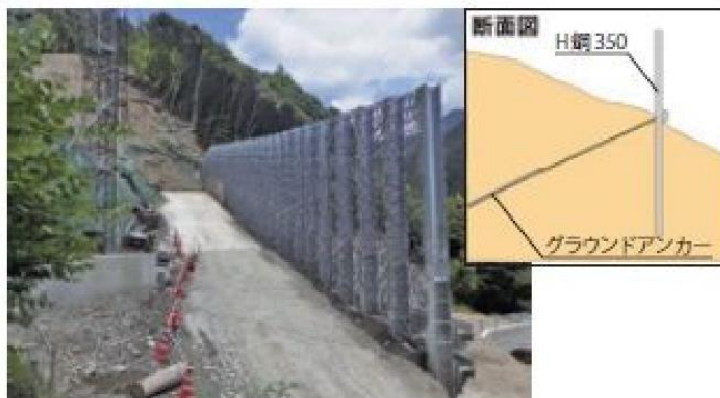
図-Ⅱ.7 立川橋の復旧時のリスク低減対策 7)
