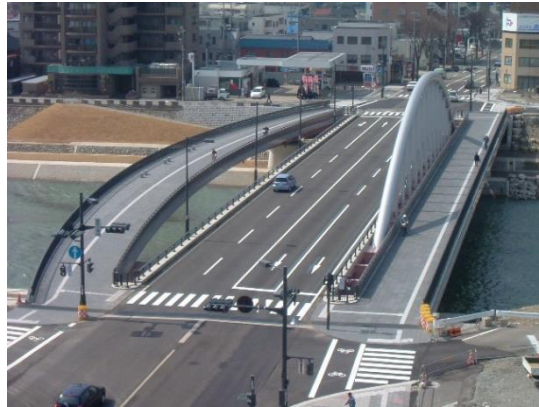
写真-4.3.8 御影大橋全景 12)
