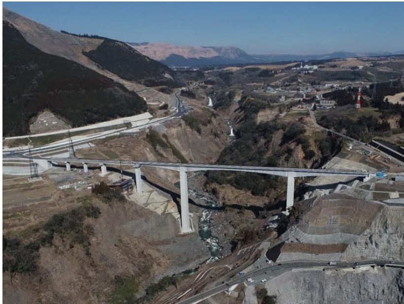
写真-Ⅱ.5 阿蘇大橋復旧全景 5)
