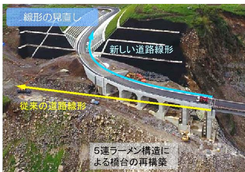
図-Ⅱ.4 阿蘇長陽大橋のA1 橋台復旧状況 3)
