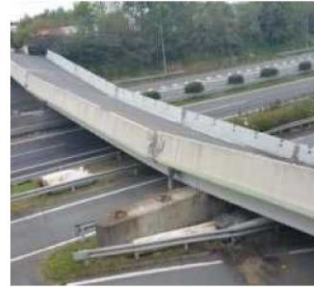
写真-IV.2 ロッキング橋脚の落橋 3)
