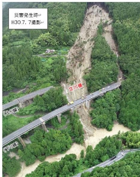
図-4.3.9 立川橋の被災状況 10)
