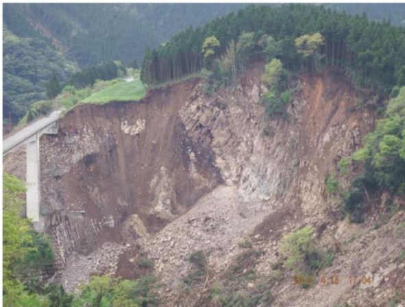
(b) A1橋台北側斜面の崩落 (4月18日撮影)
