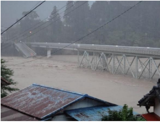
写真-4.3.2 折立橋の被災状況（増水時） 13)
