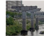
コンクリート部材(橋脚)
