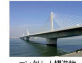
コンクリート構造物 (エクストラドースト橋)
