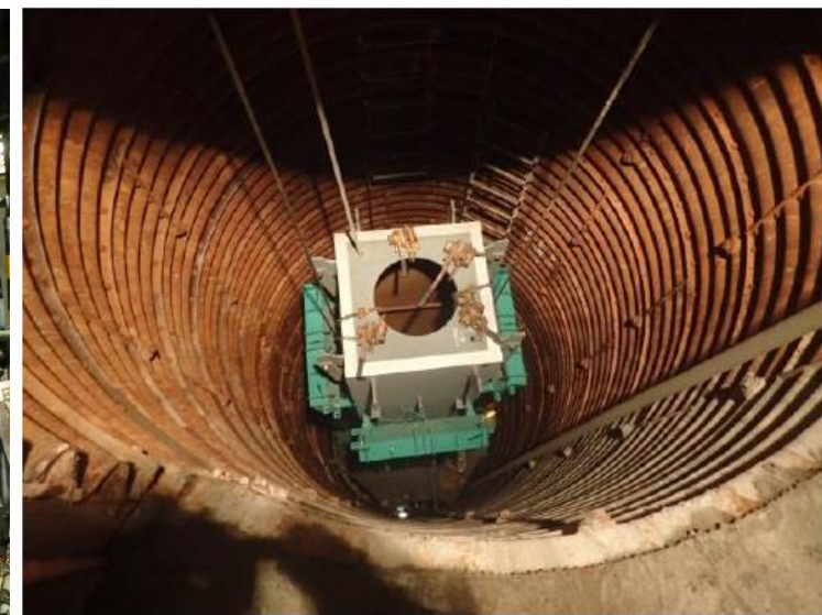
深礎内への鉄骨降下
