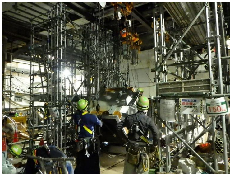
鉄骨建て起こし
