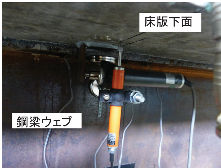
床版と鋼フランジの開き変位計測
