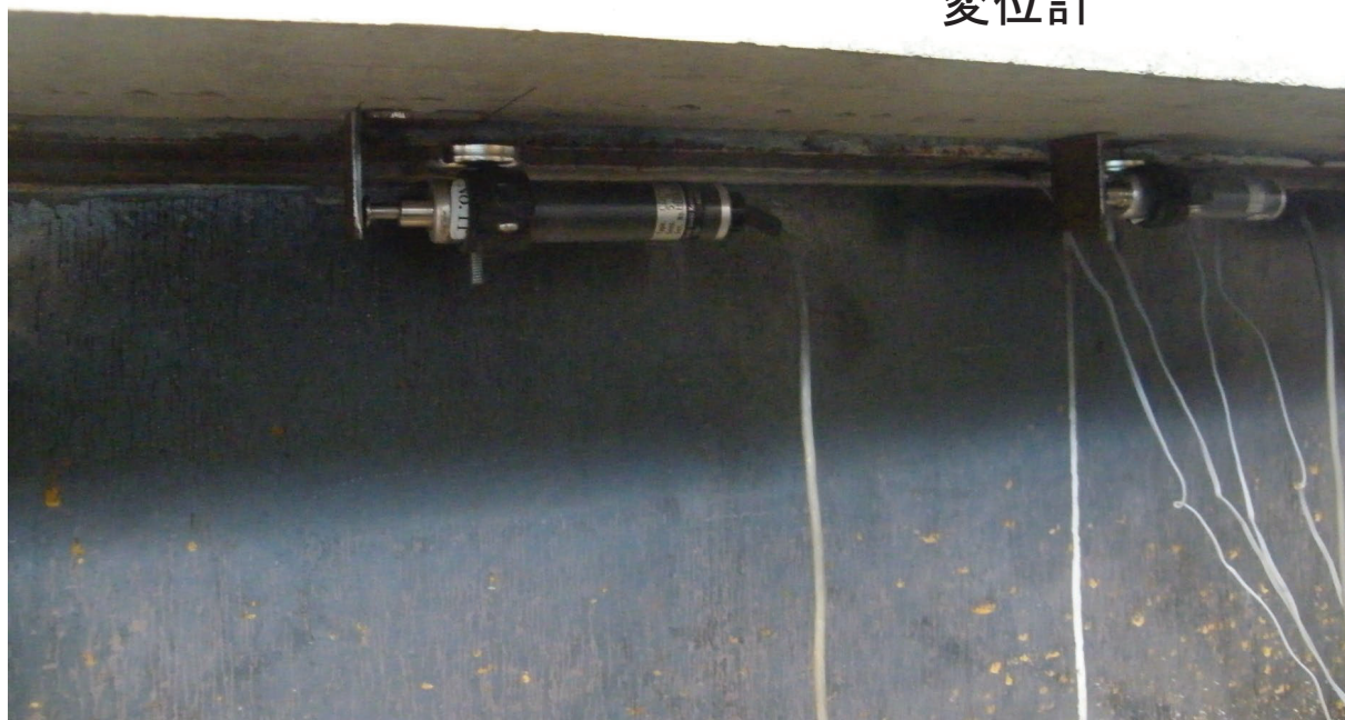
ずれ変位の計測状況
