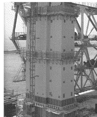
写真 7.11.2 工事用エレベーター
