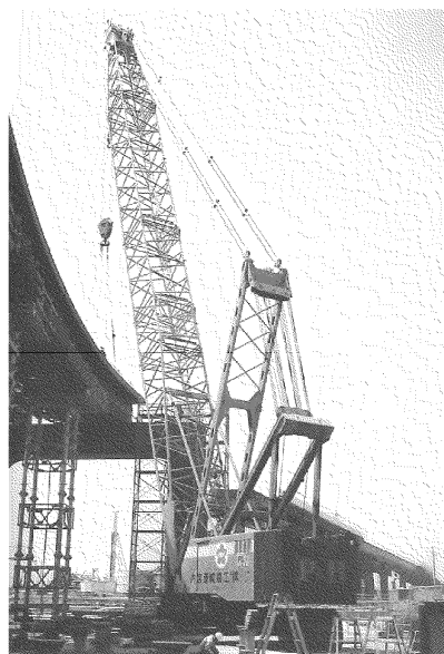
写真 7.3.17 移動式クレーン
