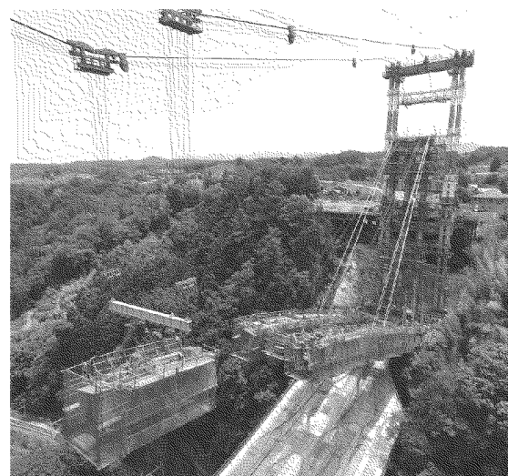
写真 7.3.9 ケーブルクレーンでの部材運搬状況
