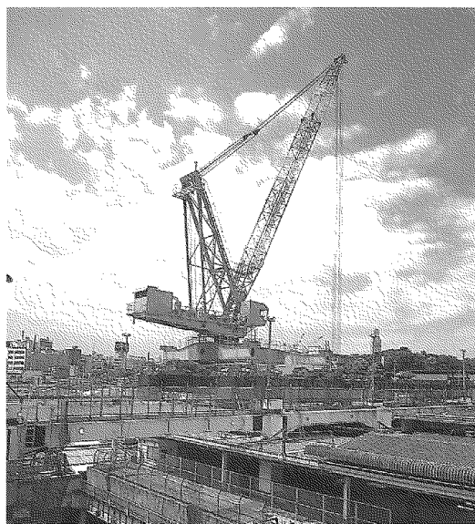
写真 7.3.4 全旋回式ジブクレーン
