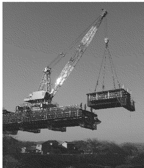
写真 7.3.3 全旋回式ジブクレーン
