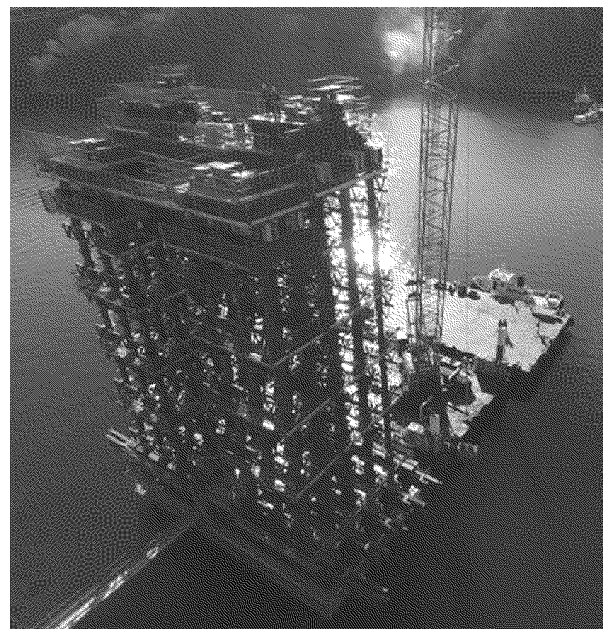
写真 7.12.3 大型ベントの使用例
