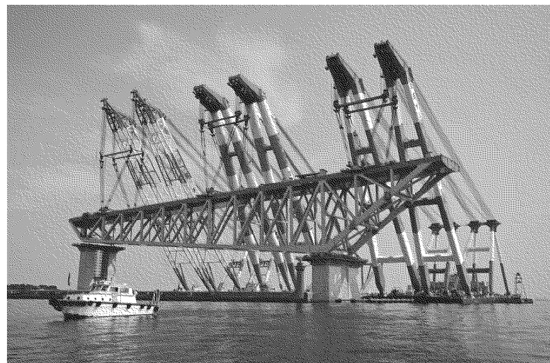
写真 7.4.4 起重機船3隻による相吊り (東京ゲートブリッジ)
