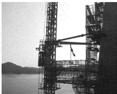
写真 7.11.2 工事用エレベーター
