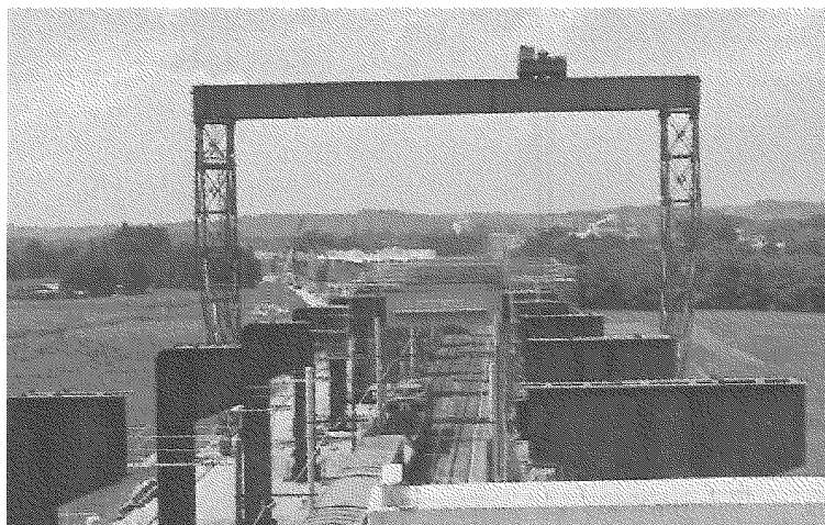
写真 7.3.8 橋形クレーン (ウインチ搭載型)
