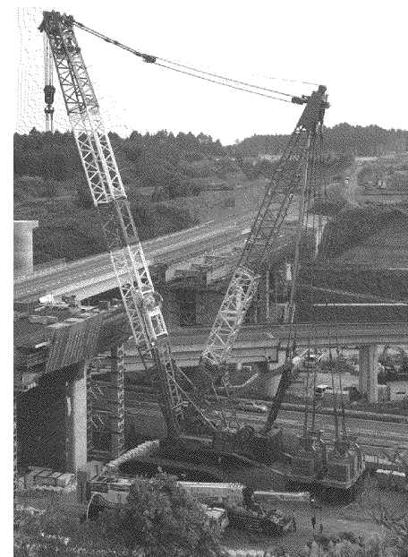
写真 7.3.17 移動式クレーン (大型クローラクレーン)
