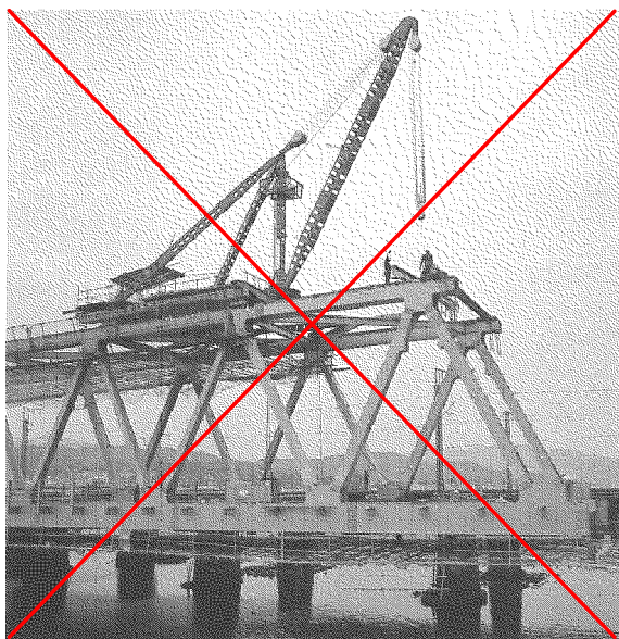
写真 7.3.3 三脚式ジブクレーン
