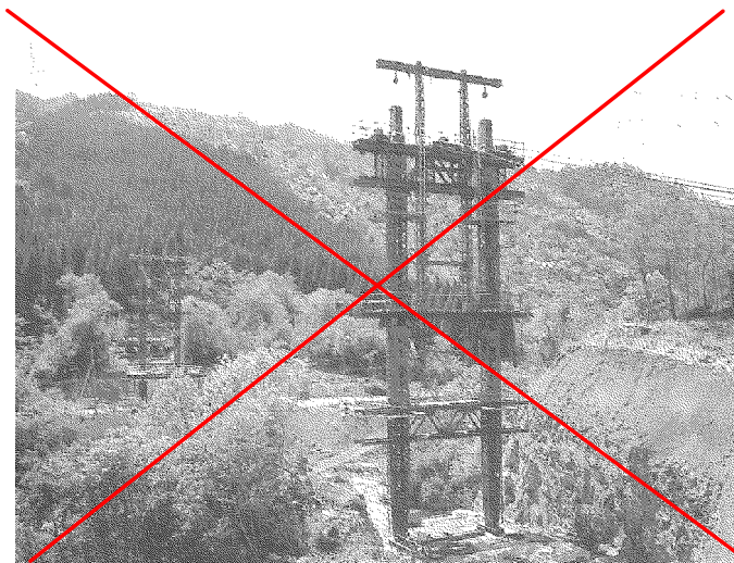
写真 7.3.12 ケーブルクレーン鉄塔のエレクター
