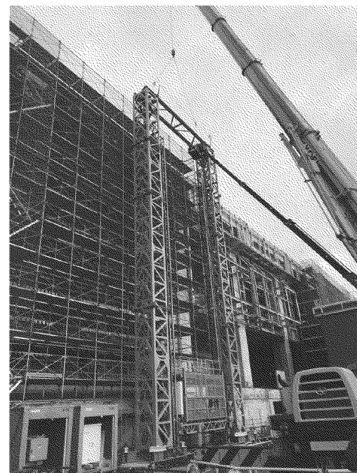
写真 7.11.4 建設用リフト
