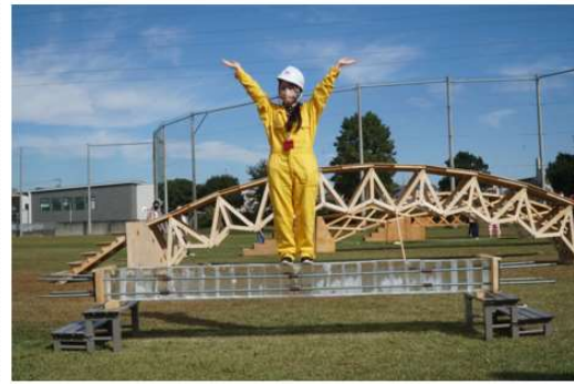
写真 6-28 世界初の Prestress Ice 橋スパン 3m
