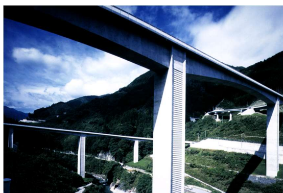
写真 6-1 雷電廿六木橋（1998 年竣工）
