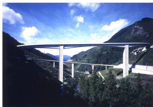
写真 6-2 滝沢ダム着工前の雷電廿六木橋
