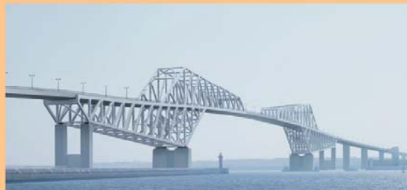
東京ゲートブリッジ(約2.6km)
