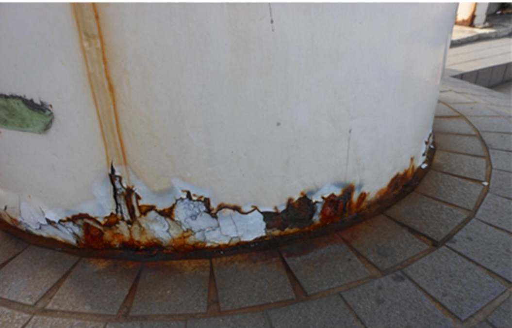
那覇市内橋脚基部の腐食状況
