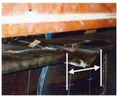
(a) 垂直補剛材間に腐食が1箇所の場合
