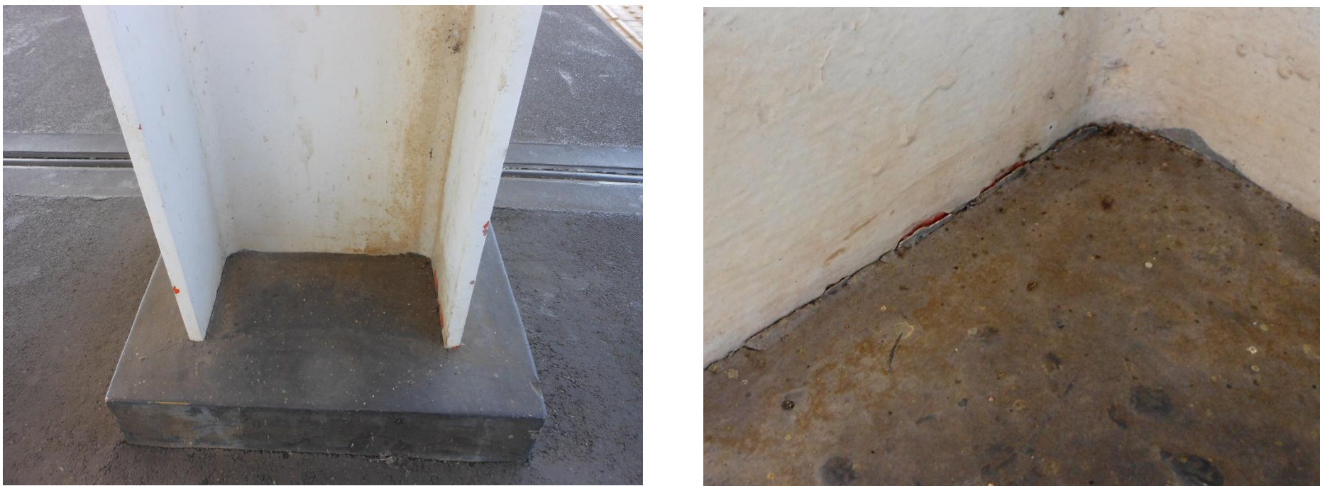
鋼製柱基部
