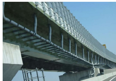
排水管追放! のきっかけとなった高架橋
