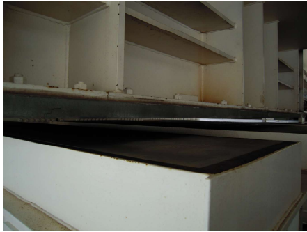
桁を支える，塔の中間梁の台座
