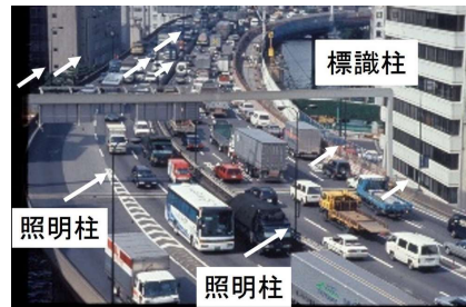
照明柱, 標識柱が倒れたら
