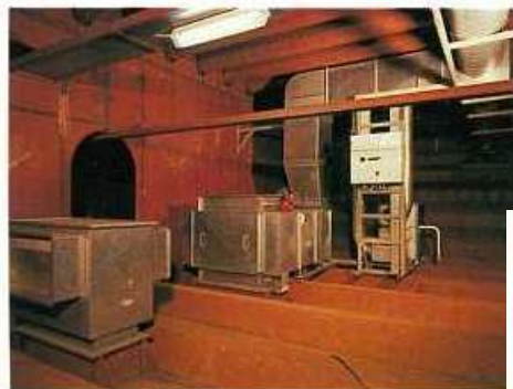
桁の中は、 塗装ではなく、 密閉して除湿で
