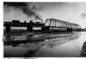
明治30年代の隅田川橋梁
