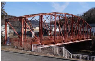
全景（平成27年12月）
