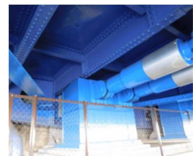
端横桁のパネルに ダンパーを設置
