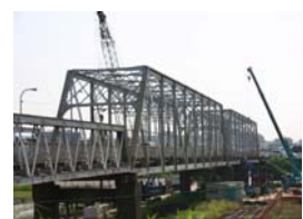
江ヶ崎跨線橋(2009年) 22
