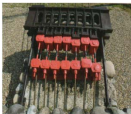
腐食進展しているケーブルの両側に新規ロッドを追加しケーブルの負担軽減
