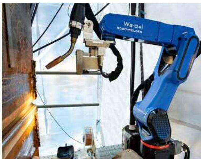
写真 3-2 建築ロボット例（溶接ロボット）
