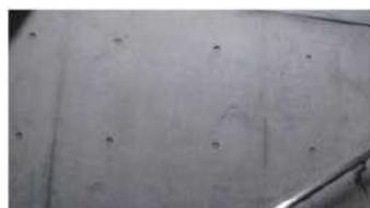
写真-10 Basilisk MR3 を用いた補修後
