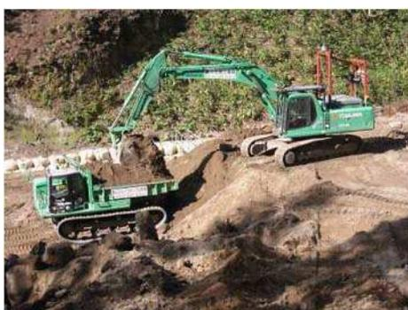
写真-1 バックホウおよびダンプの無人化施工の様子
