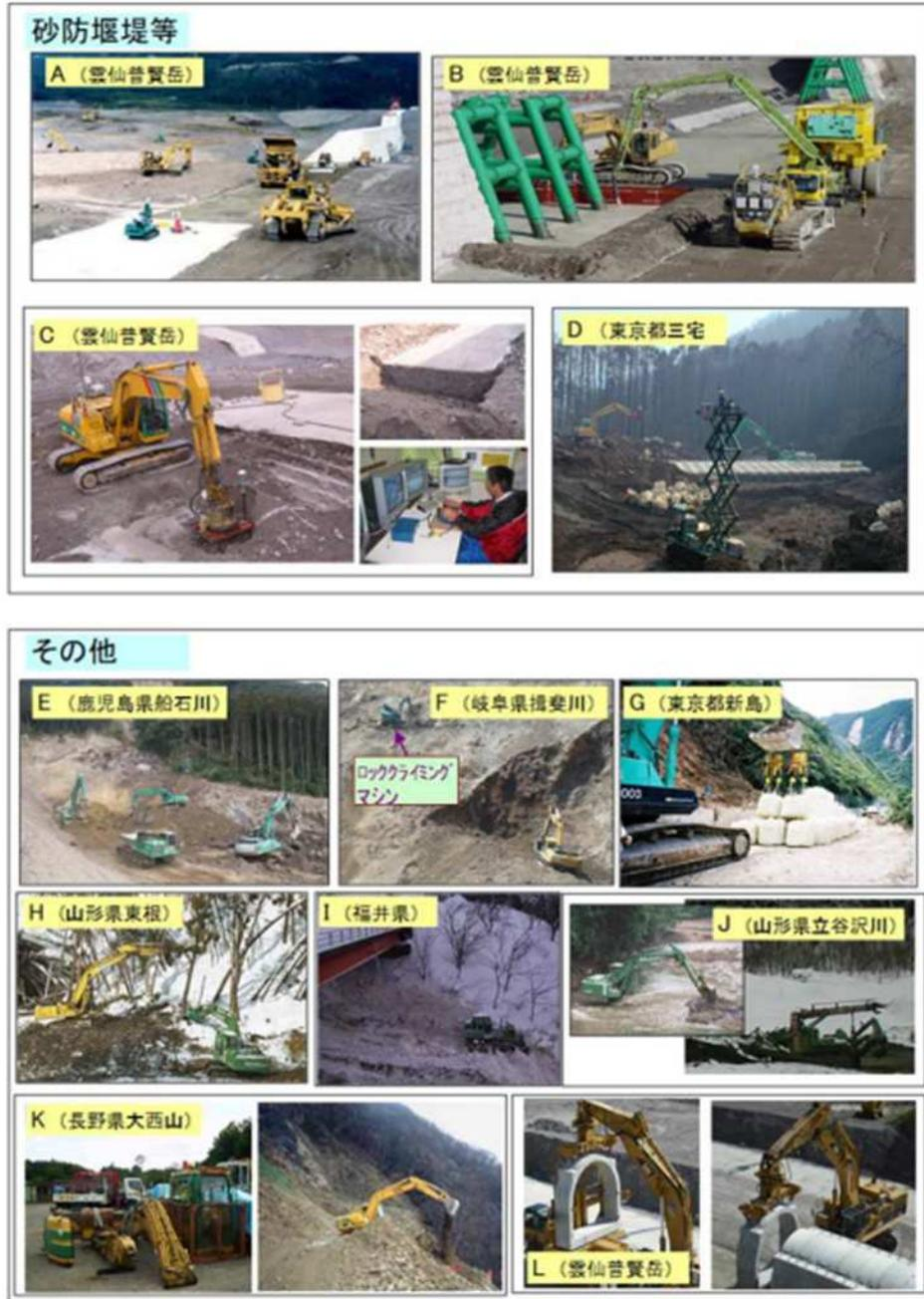
図-3 無人化施工で適用可能な工種
