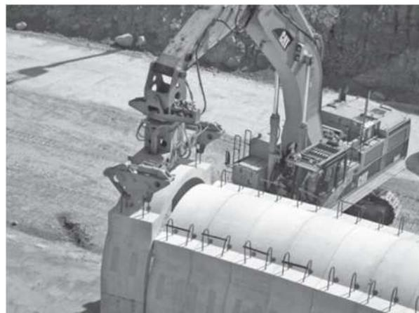
写真-4 アーチカルバート運搬・据付状況
