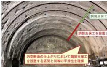
写真2：鋼製支保工を設置しない区間における内空断面の仕上がり
