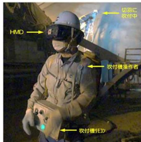
吹付機操作者、切羽監視員、吹付ホース介添者(カメラ移動補助)は切羽直近からは離れた位置で作業
