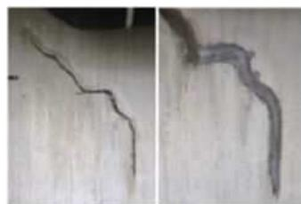
写真-9 Basilisk MR3 を用いた補修（左：補修前、右：補修中）
