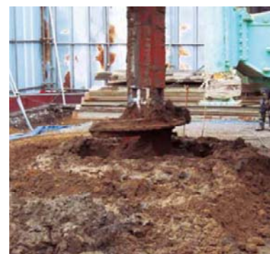
写真 原位置攪拌混合機による施工状況
