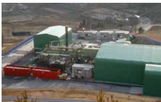
実機設備設置状況
