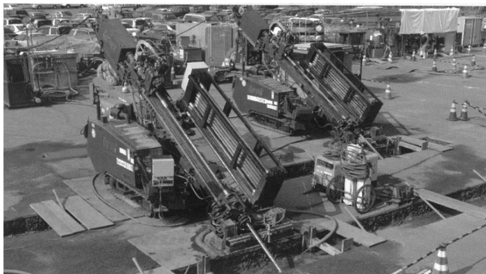
CurveX(水平自在ボーリング)施工機
