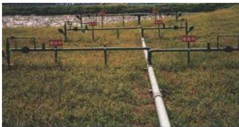
吸引井戸配置状況写真
