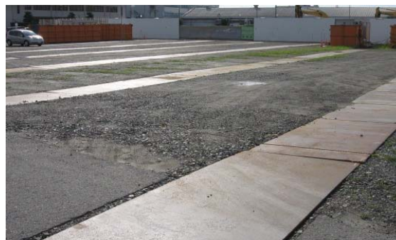
薬材浸透時の写真(地上部利用の場合)
