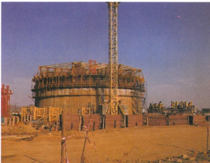
写真-3 煙突（高さ 273m）の 在来型スリップフォーム施工状況 4)
