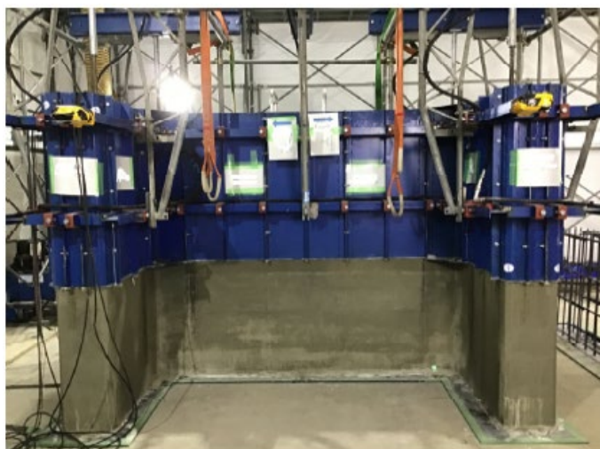
写真-5 港湾のケーソン用モックアップテスト例
