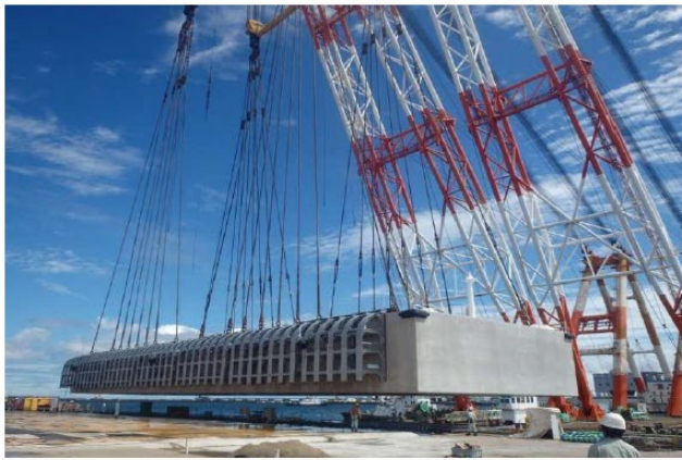
↑浮防波堤FC進水 据付完了⇒
