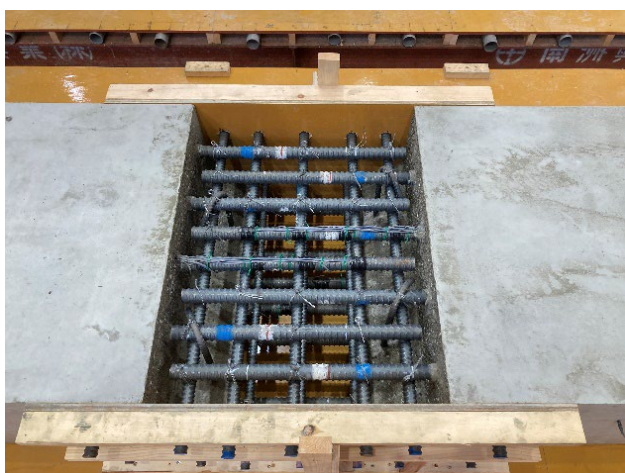
写真-6 実構造物の配筋を再現した継手部の配筋状況
