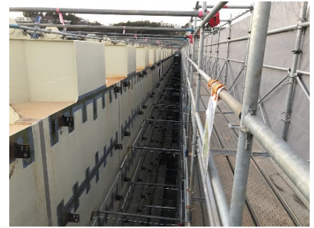
写真-6 支保工解体後の足場
