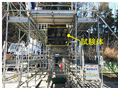
写真-1 試験施工状況
