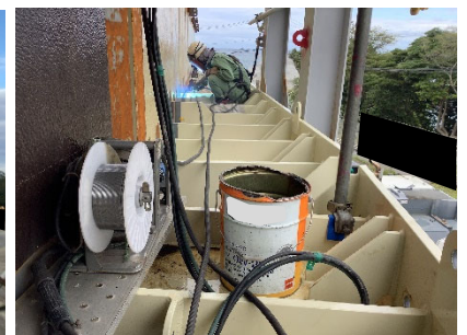
写真-12 半自動溶接
