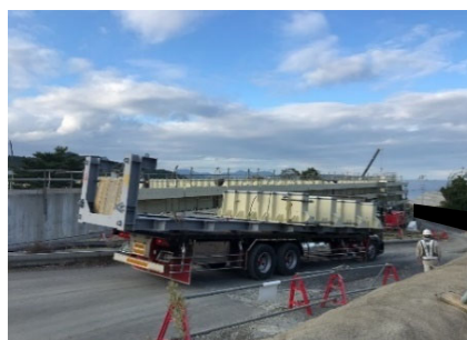
写真-11 場内運搬状況
