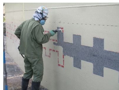
写真-3 平ノミでの塗装除去
