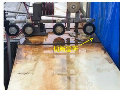
写真-9 頂部梁切断状況
