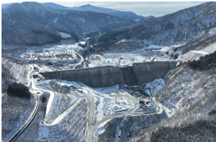
写真-1 CSG打設完了後の成瀬ダム
