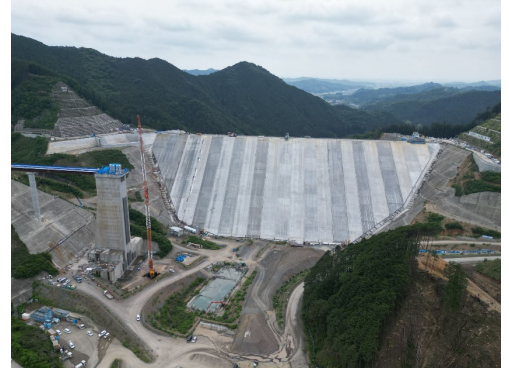
写真-1 堤体上流面
