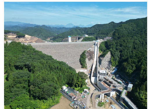
写真-2 堤体下流面
