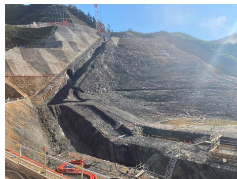
写真-5 プリンス基礎岩盤
