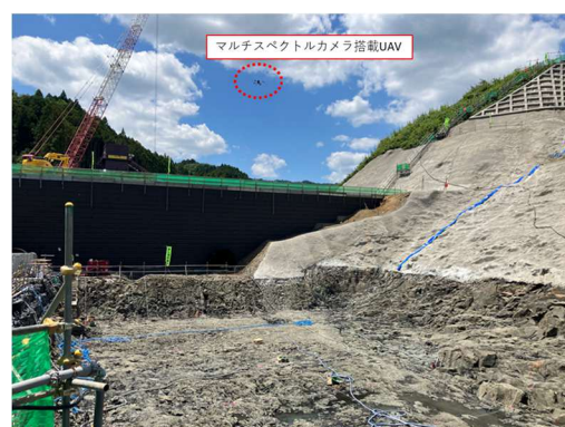
写真-4 マルチスペクトルカメラ搭載 UAV による撮影状況
