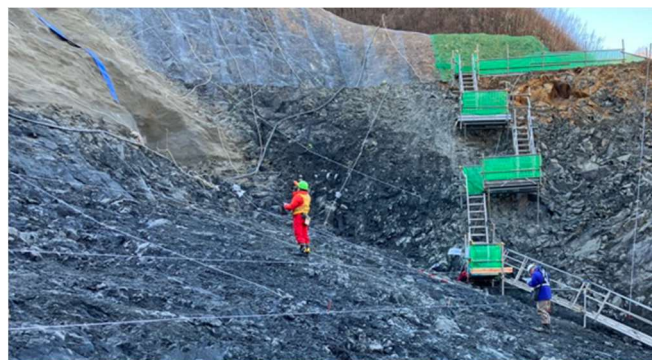
写真-1 地質技術者による基礎岩盤評価
