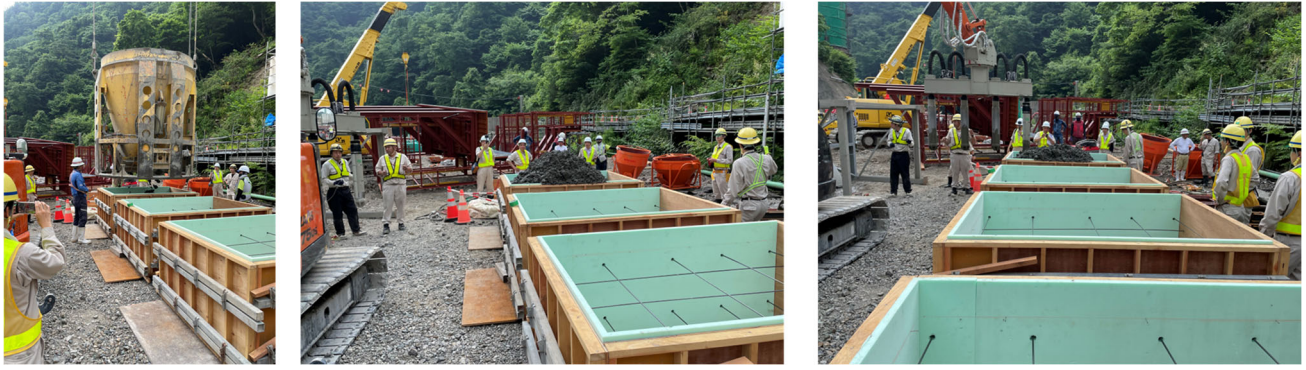
写真-2 型枠内締固め試験状況
