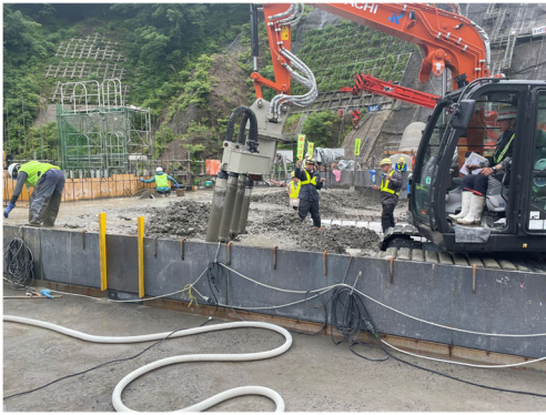
写真-5 現場における均し作業状況
