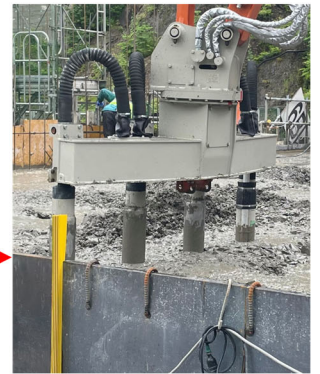
写真-6 現場における締固め作業の計測状況
