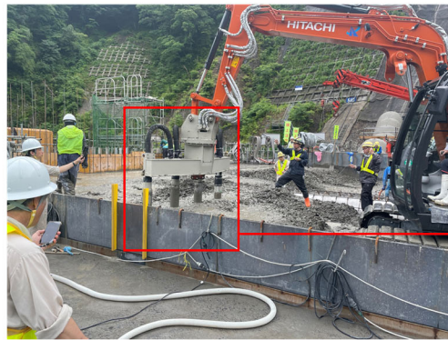
写真-6 現場における締固め作業の計測状況
