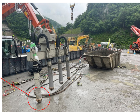
写真-1 加速度計アダプタ取付け状況
