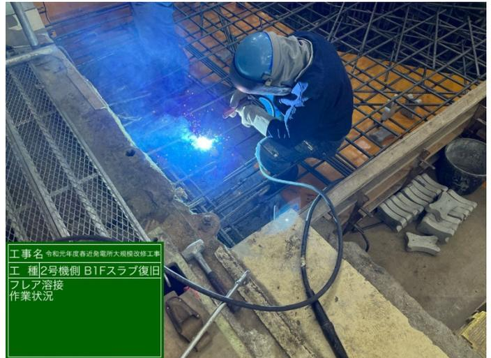
写真-2 既設鉄筋の接続状況（春近発電所）
