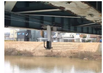
図-4 ロボットを用いた計測方法
